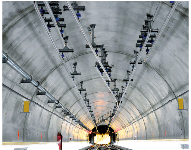
TracFeed® OSS Oberleitungsstromschiene
