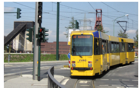
Fahrleitungsanlagen – Ausführung als Hochkette
