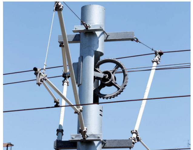
TracFeed® NSV Halbintegrierter Radspanner
