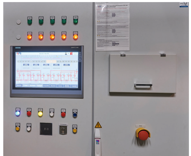
Stetige Zustandsinformationen der Anlage und schlüsselgestützte Verriegelungsfunktionen
