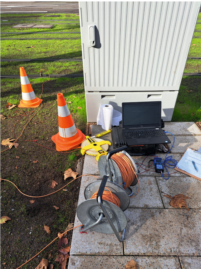
Messungen von Ableitbelägen
