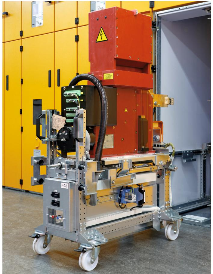
Schaltwagen mit GE Gerapid Gleichstrom-Schnellschalter
