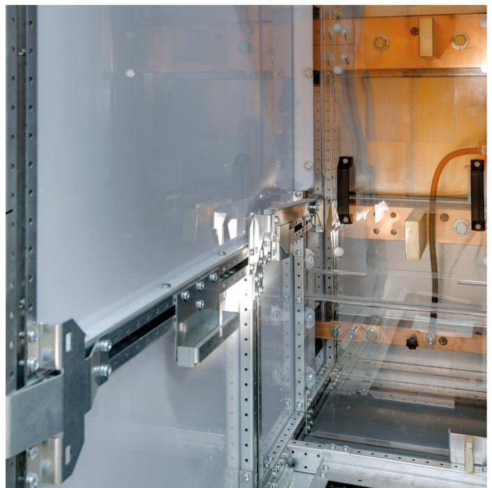
Blick in das Leistungsschalterfeld – im Vordergrund der Leistungsraum, hinter dem Shutter der Sammelschienen- und Kabelanschlussraum
