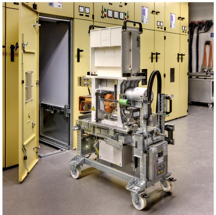
Schaltwagen mit Sécheron UR-Gleichstrom-Schnellschalter
