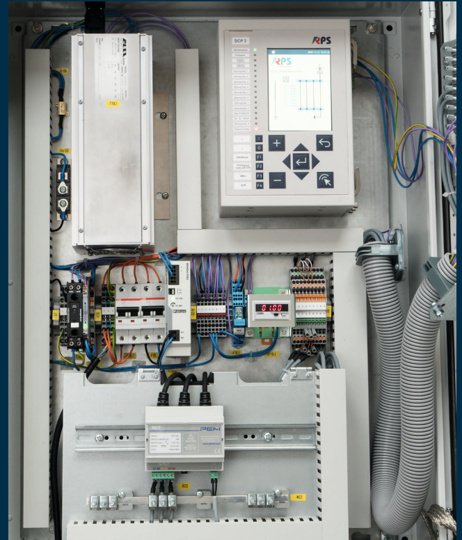
Innenansicht vom Schaltschrank des Überwachungssystems TracFeed® RCM
