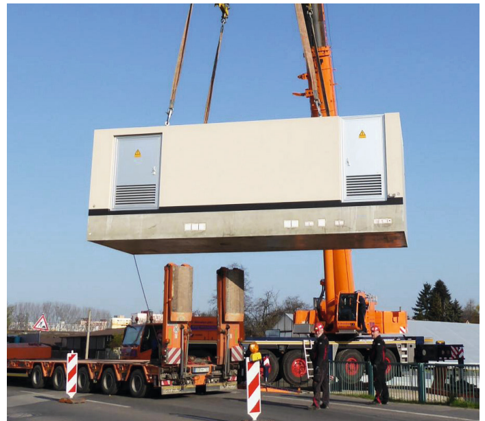
Betonausführung des kGUWs wird vom Transporter gekrant
