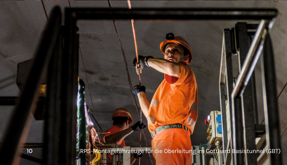
Dynamische Abnahmefahrt für die Oberleitung im GBT mit 275 km/h
